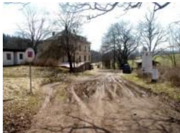
HP před položením asfaltu – pohled z polské strany
