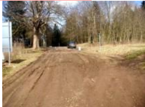
HP před položením asfaltu – pohled z české strany
